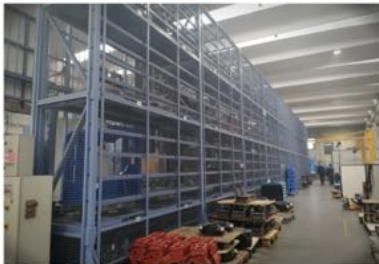
Flexibilità per la linea FMS MCM TANK 1300 in Meccanica Ponte Chiese | magazzino pallet
